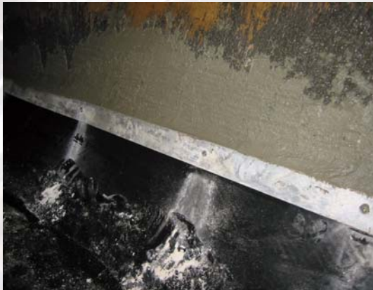
Coffrage et finitions par la pose de baguettes INOX
